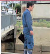
大雨で増水した瀬戸川と幣塚橋を確認
