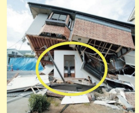
家屋倒壊後も残る「耐震シェルター」
