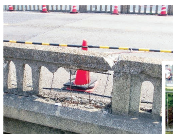
老朽化が著しかった幣塚橋
