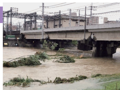
増水時には障害物となる橋台
