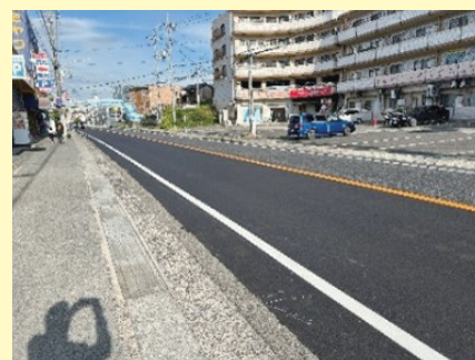
舗装補修後の国道2号
