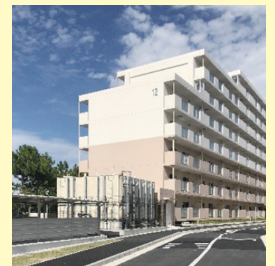
エレベーター設置が進む県営住宅
