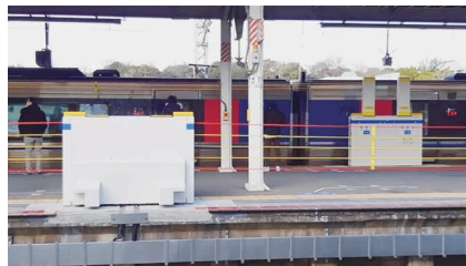
ホームドアが設置された明石駅3・4番線ホーム
