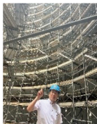
工事中の汚泥貯留槽
